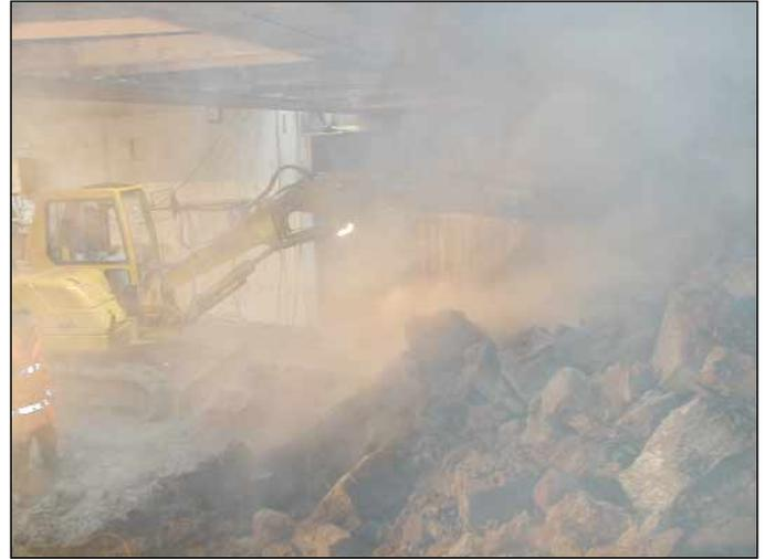
**Abb. 5: Ortsbrust beim Einpressen mit Abbau der Frostplatte**
